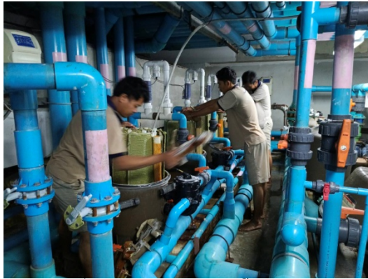
ภาพที่ 5-38 ดูแลรักษาสระว่ายน้ำ น้ำและตรวจวัดค่า pH , Chlorine Free เป็นประจำทุกวัน
