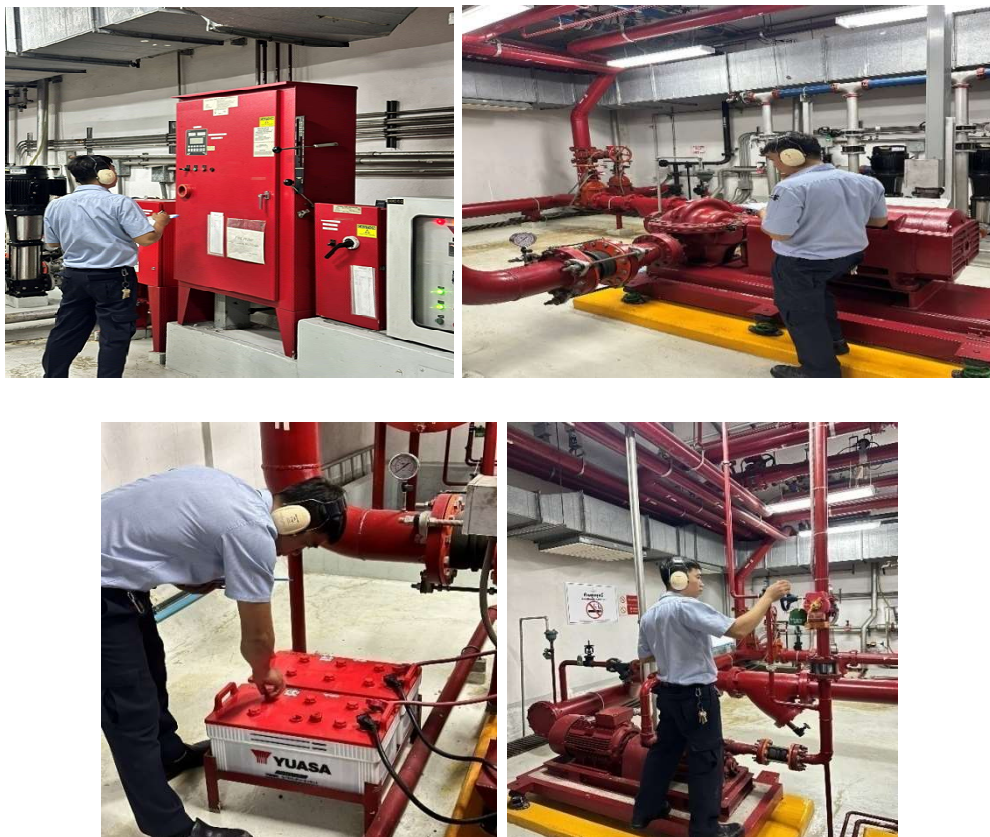
ภาพที่ 5-36 ตรวจสอบดูแลซ่อมบำรุงระบบสูบน้ำดับเพลิง (Fire Pump)
