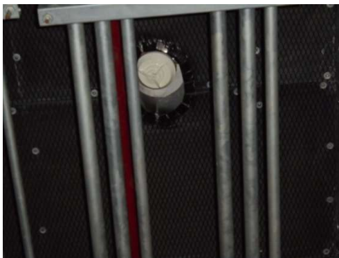
เครื่องตรวจจับความร้อนในห้องเครื่องกำเนิดไฟฟ้าฉุกเฉิน และเครื่องตรวจจับควันในห้องพักแขก
