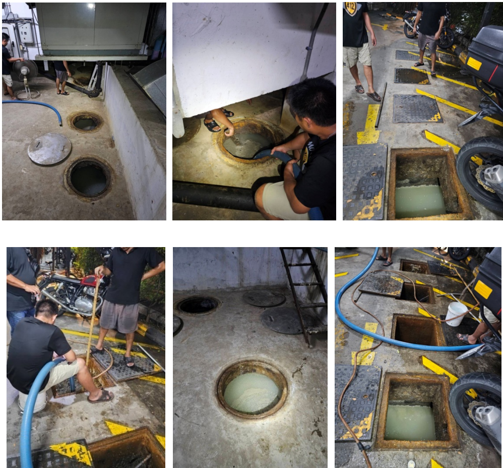
ดูสิ่งผิดปกติจากบ่อดักไขมัน และเติมสารชีวภาพในบ่อดักไขมัน ภาพที่ 5-27 ดูตะกอนไขมันและตะกอนในบ่อกับตะกอนของระบบบำบัดน้ำเสีย
