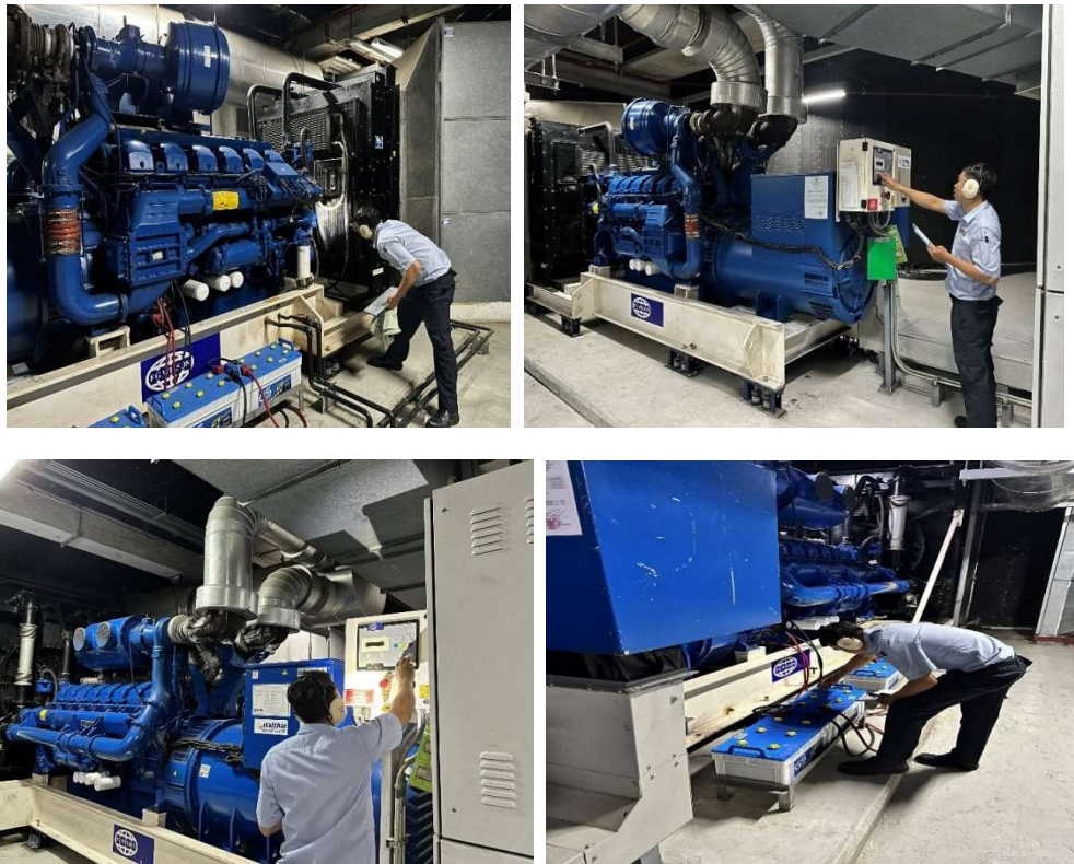
ภาพที่ 5-35 ตรวจสอบดูแลซ่อมบำรุงระบบเครื่องกำเนิดไฟฟ้าฉุกเฉิน (Generator)
