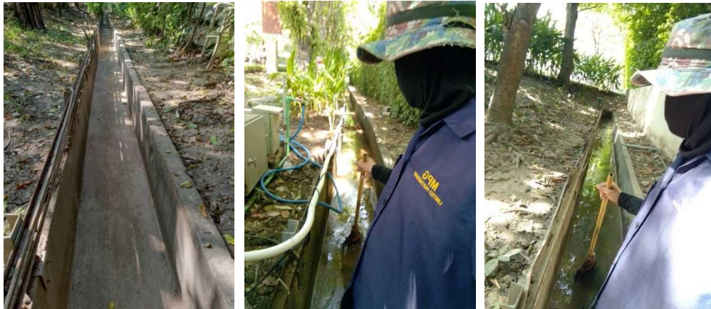
ภาพที่ 5-29 ตรวจสอบสภาพรางระบายน้ำไม่มี และขุดลอกรางระบายน้ำและบ่อพักน้ำอยู่เสมอ
