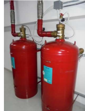
ถังดับเพลิงเคมีและระบบหัวกระจายน้ำดับเพลิงภายในห้องไฟฟ้า MDB
