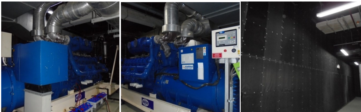
ที่ 5-26 ห้องเครื่องไฟฟ้าฉุกเฉินมีระบบขนวนป้องกันเสียงดัง ปล่องไอเสีย และเครื่องตรวจจับความร้อน
