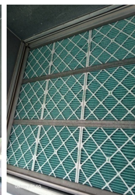
ภาพที่ 5-41 ตรวจสอบระบบการระบายอากาศประจำปี และล้างแผ่น PAU ทุกๆ 6 เดือน
