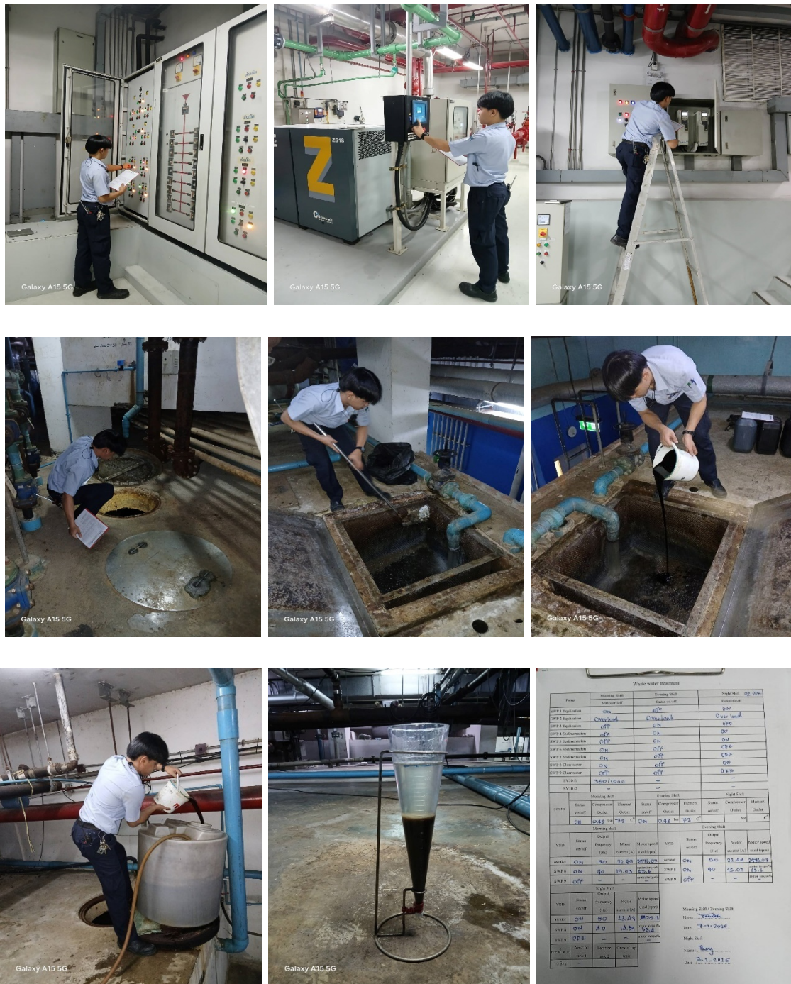
ภาพที่ 5-34 การตรวจสอบดูแลซ่อมบำรุงระบบบำบัดน้ำเสีย
