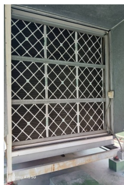
ภาพที่ 5-41 ตรวจสอบระบบการระบายอากาศประจำปี และล้างแผ่น PAU ทุกๆ 6 เดือน
